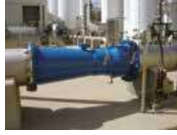
الشكل (33): مقياس فنتوري في إحدى محطات المياه.
